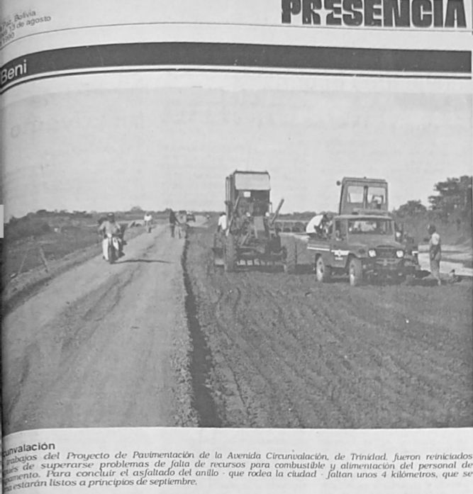
Trabajos del Proyecto de Pavimentación de la Avenida Circunvalación, de Trinidad, fueron reanunciados tras superar problemas de falta de recursos para combustible y alimentación del personal de mantenimiento. Para concluir el asfaltado del anillo - que rodea la ciudad - faltan unos 4 kilómetros, que se estarán listos a principios de septiembre.
