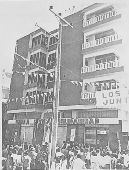
Edificio de UCS
