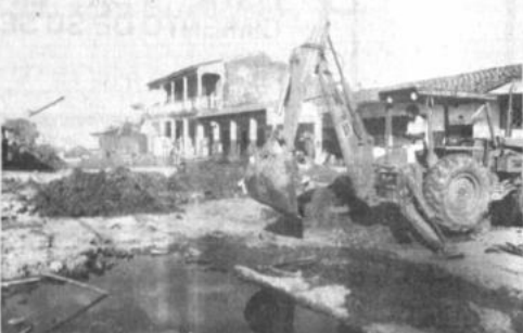
Alcantarillado y enlasetado en las calles céntricas de Trinidad que realiza la Corporación Regional de Desarrollo del Beni.
