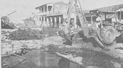
Alcantarillado y enlucido en las calles céntricas de Trinidad que realiza la Corporación Regional de Desarrollo del Beni.
