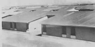
Las 127 casas otorgadas hoy - 53 a trabajadores aportantes al FONVI y 74 a adjudicatarios pertenecientes a otras agencias de la H. Municipalidad. Tienen una superficie construida de 14 mil m 2 en lotes de 180 m 2 . Contando de 3 dormitorios, baño, cocina y lavandera. En sus techos más modernas técnicas de aislamiento plástico que han mejorado la calidad de vida.
