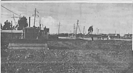
Se inició la apertura de la avenida Pnnorámica en el sector sur de la ciudad de El Alto, esa vía vinculará a los valles del sur con la Ceja y permitirá el descongestionamiento vehicular de ese lugar.
