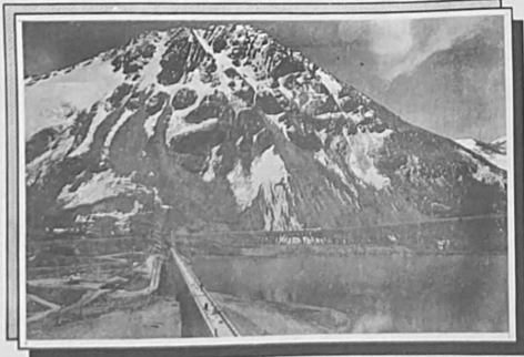
PRESA DE INCACHACA
