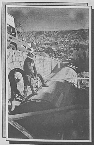
EMBOVEDADO RIO TACAGUA
