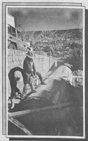
EMBOVEDADO RIO TACAGUA
