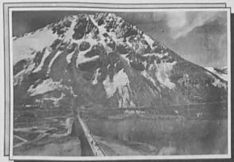
PRESA DE INCACHACA
