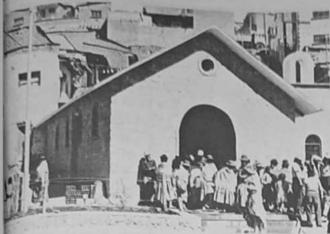
Obra en Villa Nueva Potosí
