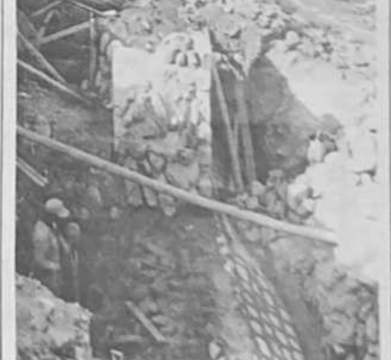
Reparaciones En el sector del puente Pucos Karak, entre Miraflores y Villa Copacabana, la alcaldía paceña está reparando el muelle de empuje del río Orghuñu.
