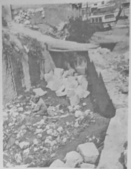
Canalización En la calle Tito. Rubén Amézaga, zona de Achachicola, la Alcaldía de La Paz, con apoyo financiero del Fondo de Inversión Social, FES, está embalsando el río matadero en una extensión de 100 metros. Los trabajos concluyeron en agosto próximo.
