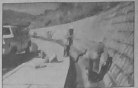
Mantenimiento de la Av. Kantutari
