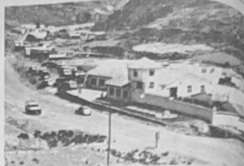
NUEVO HOTEL. El nuevo hotel "El Tambor" se encuentra en construcción para el desarrollo urbano y el fortalecimiento de la industria turística. El nuevo hotel se levantará sobre la carretera asfaltada Potosí-Tarapaya.
