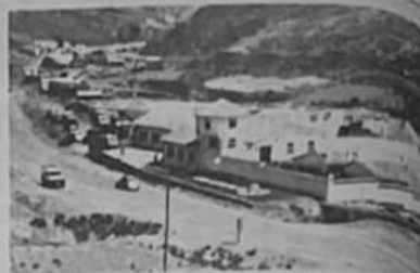
NUEVO HOTEL. El nuevo hotel "El Tumbó" se encuentra en construcción para el desarrollo urbano de Potosí, fortaleciendo de la industria turística. El nuevo hotel se levantará en la zona de Potosí Tarapaya.
