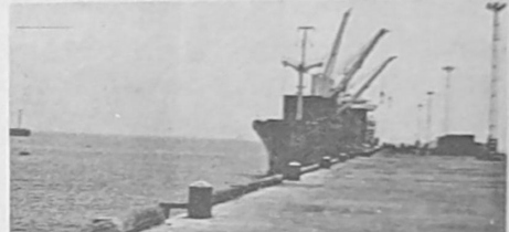
Muelle del puerto de Ilo
