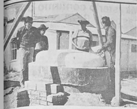
Pruebas de biodigestor... El Ing. Raúl Vidal, gerente de Producción de CORDEOR, y otros técnicos realizaron pruebas de biodigestor...
