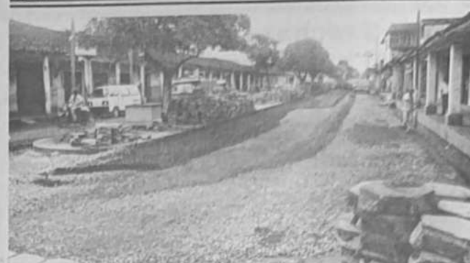
Reparación de avenida. Los alcaldes municipales visitaron ayer la obra de reparación de la avenida 6 de Agosto para evaluar el avance de los trabajos. (Foto: Juan Carlos Zaldívar)
