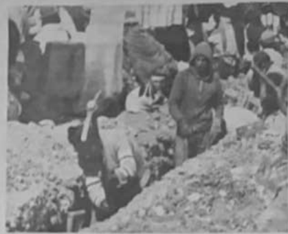
Los trabajos de la instalación del alcantarillado en la zona de Alto Lima se aceleraron.
