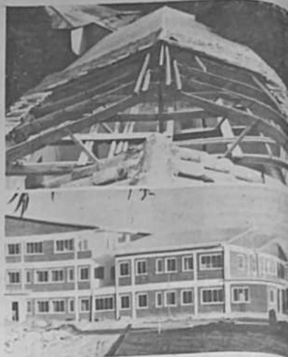
Hospital de CNS. Las nuevas instalaciones del Hospital de la Caja Nacional de Seguro Social en Tarija, empezaron a demolerse por lo que las autoridades determinaron su pronta traslado a las nuevas instalaciones modernas edificadas hace 8 meses. En el gráfico superior se muestra las deterioradas instalaciones del hospital. En el gráfico inferior el moderno edificio, en el que funciona el Hospital de la CNS.
