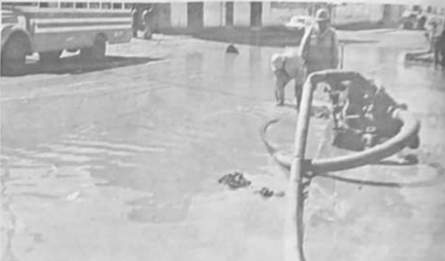
Obreros del retén de emergencia bomban aguas estancadas de la lluvia en la Av. Estrella Sur, en Alto San Antonio.
