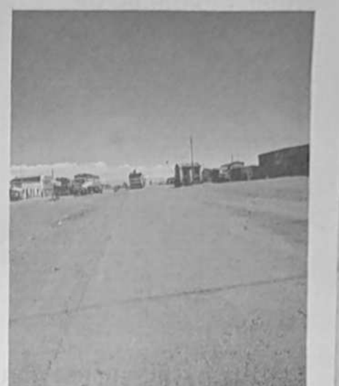
Recapamiento El Ministerio de Transportes y Comunicaciones para la presente gestión, tiene unos programas para construir nuevos caminos y mejorar algunos carreteras.
