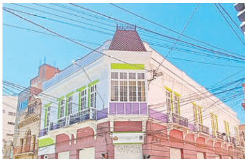
Colores cuestionados en fachada del edificio del Ministerio Público / RR SS
