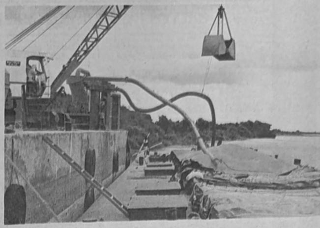
Proceso de succión de granos. En Puerto Aguirre, luego que se descargaron los granos de trigo, se procedió a la succión de los mismos, con una moderna instalación de equipos, que con un trabajo efectivo, logran transportarlo a través de cintas sin fin, hasta el principal silo que tiene una capacidad de 90.000 toneladas de almacenaje.
