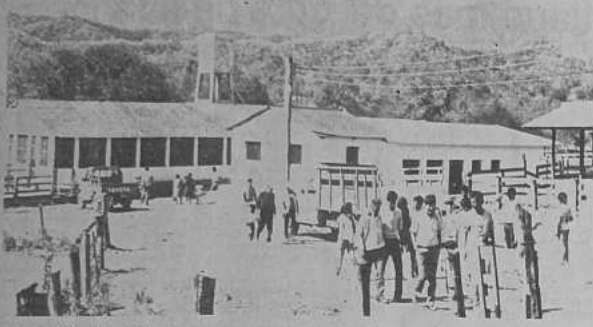
Industrializadora de leche CORDECH inauguró en Iboperenda, 7 kilómetros de Muzupampa-Chuquisaca, una planta moderna que procesará la producción lechera de la zona con importantes cantidades de ganado vacuno y bovino. (Foto S.V.C.)
