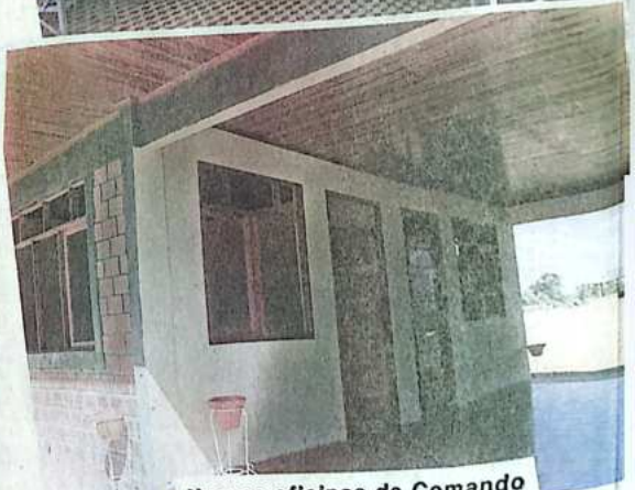
Nuevas oficinas de Comando
