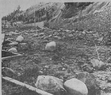
Derrumbes en Parque Central
