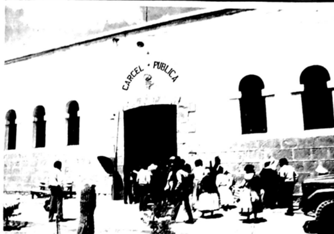
Deterioro de cárcel pública.
