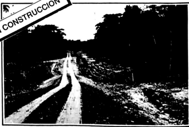
CARRETERA LA PAZ-TRINIDAD (TRAMO QUIQUIBEY-YUCUMO)
