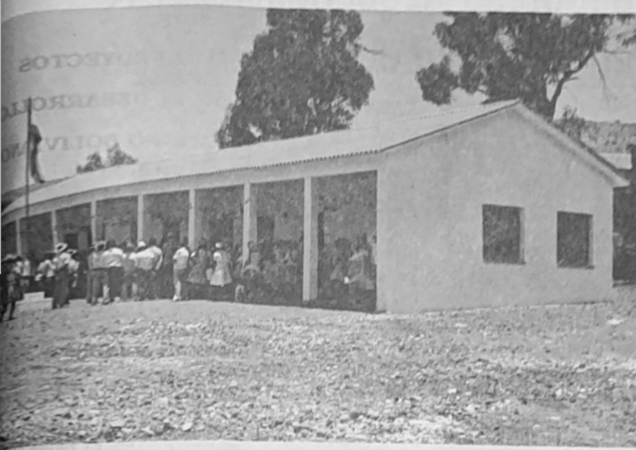
Escuela rural en la localidad de Gamonedá, Provincia Cercado, departamento de Tarija, la Corporación Regional de Desarrollo construyó varias escuelas con financiamiento del Fondo Social de Emergencia.
