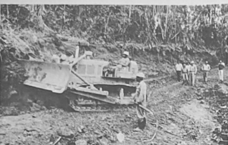
Apertura de camino
