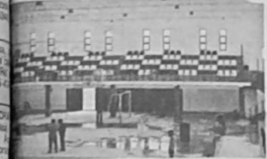
COMPLEJO DEPORTIVO MUNICIPAL (Vista interior)
