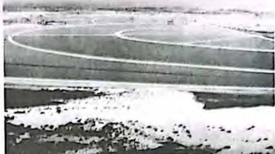
En las dunas de arena del sur de Tel Aviv, funciona una de las plantas de tratamiento de aguas residuales más grandes del mundo.
