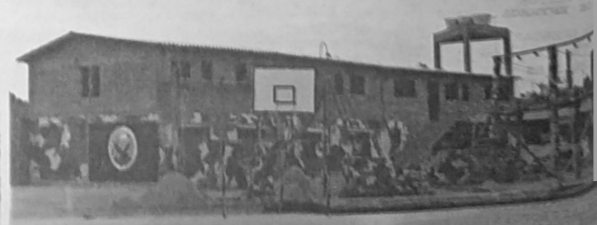
Construcción de viviendas para OO. solteros
