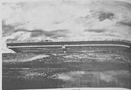
Puente Chilla Abril 89
