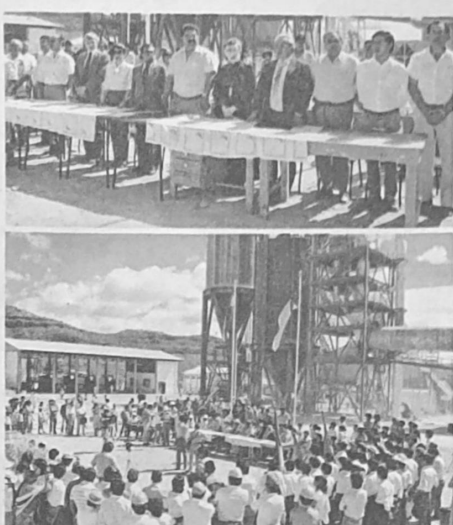
FABRICA DE CEMENTO.- TARIJA. (PRESENCIA) En un acto especial, el gerente general de la Corporación Regional de Desarrollo de Tarija Manuel Vázquez Baldutis, inauguró la etapa de producción de la fábrica de cemento "El Puente".
