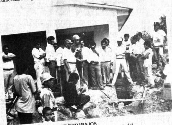
INICIANDO TRABAJOS (Terminal aeroportuaria de Monteagudo).
