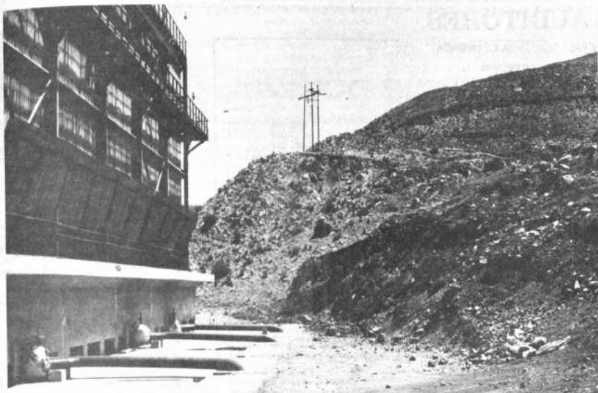
DAÑOS.- En determinados sectores del lugar presentado derrumbes y desprendimientos de tierra donde se encuentra la planta de volatilización de La Palca (a 15 kilómetros de la Villa Imperial), se han que han dañado la estructura de esta costosa plan- ta, paralizada hace más de tres años.
