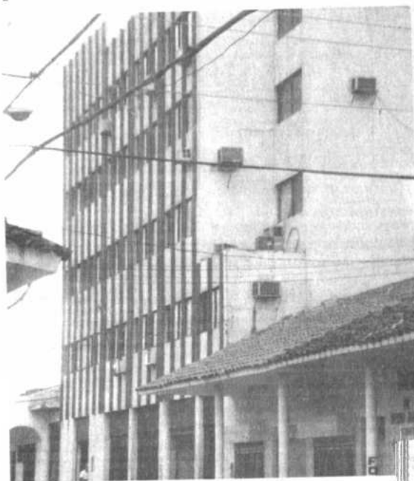
BIBLIOTECA PUBLICA.- SANTA CRUZ (PRESENCIA) El edificio de la Cámara de Industria y Comercio en Santa Cruz, donde el directorio de la institución decidió instalar en el primer piso una biblioteca pública como un aporte a la cultura popular, en la segunda planta funcionará una feria exposición permanente de productos de la industria y artesanía cruceña (Foto PRESENCIA)
