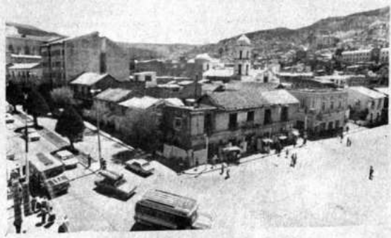
CASA AZUL.- Es la esquina conformada por la plaza Alonso de Mendoza y Avenida América de la ciudad de La Paz, se encuentra un antiguo edificio conocido por los paceños como la "Casa Azul", infraestructura que ya ha mostrado su debilitamiento y deterioro. (Foto 1).
