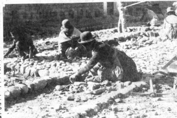
HORARIOS. Los trabajadores municipales y los vecinos que realizan la- bor en acción comunal en las diferentes obras de El Alto, tendrán dos turnos de trabajo. Según el alcalde Filiberto Cardozo, esta modalidad per- mitirá acelerar los trabajos municipales y lograr su conclusión de acuerdo con lo programado.
