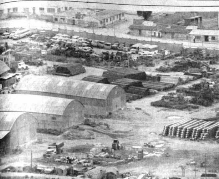
MACENES GENERALES DE COMIBOL. ciudad de Oruro, cerca a la mina San Encuentro se encuentran las instalaciones de los almacenes generales de la Corporación Minera de Bolivia. En la fotografía, una vista panorámica.
