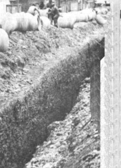
**COLECTORES.** En la carretera hacia Viacha obreros de SAMAPA instalan colectores de primer orden, para la conexión de la red de alcantarillado de diversas zonas y villas de El Alto.
