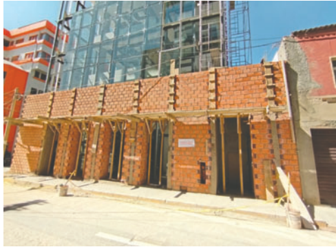
Obras de la construcción continúan, pese a notificación municipal / LA PATRIA
