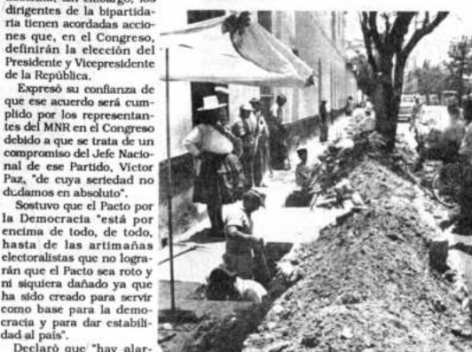
TRABAJOS, COCHABAMBA (PRESENCIA). La Empresa de Luz y Fuerza Eléctrica Cochabamba (ELFECSAM) procedió al cambio de los cables subterráneos de las calles céntricas de la ciudad con el propósito de mejorar el servicio y dar seguridad a las instalaciones internas con las que esta empresa cuenta. A la fecha se lleva a cabo el trabajo de compactación de terreno y reposición de losas.
