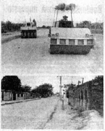
**PAVIMENTACION COTACA-PAILON.** El atraso de la temporada de lluvias en Santa Cruz, está posibilitando un adelanto en los trabajos de pavimentación de la carretera Cotaca-Pailón (Río Grande). Esta obra se realiza dentro del proyecto de pavimentación de la carretera Santa Cruz-Trinidad. Equipo del Servicio Nacional de Caminos. En la composición gráfica en pleno trabajo de compactación del suelo (Foto - PRESENCIA - SANTA CRUZ)
