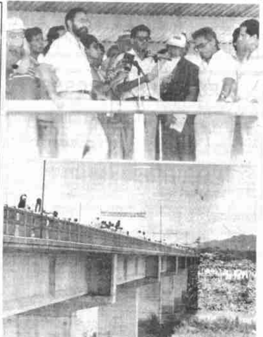
INAUGURACIÓN. En una ceremonia realizada en el puente sobre el río Ichilo, se inauguró este sábado la carretera Chimoré-Yapacaní, que mediante una entrega de la obra que beneficia a dos importantes zonas agroindustriales del país, estuvo a cargo del Superintendente de la constructora brasileña Andrade-Gutierrez. Al acto asistieron ministros de estado, autoridades de ambos departamentos, e invitados especiales. La nueva vía pretender ser a la larga, parte de la carretera transcontinental que entrará los puertos de Santos, del Brasil y Arica de Chile.
