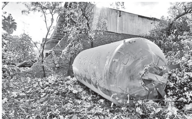
Daños causados por la explosión. UNITEL
