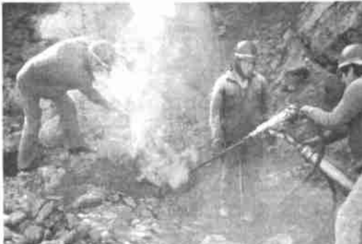
CAMINO DE PENETRACION. La Corporación Regional de Desarrollo de La Paz, con el propósito de lograr la integración del norte pacífico ha destinado importantes recursos a la construcción del camino Charazani-Apolo. En la fotografía se observa equipo pesado y obreros, quienes, pese a permanecer en una región tropical, trabajan con ropa gruesa para evitar la picadura de abejas. La población de esta región espera con esperanza la conclusión de esta vía, porque las riquezas que posee podrán ser comercializadas en los mercados de La Paz.
