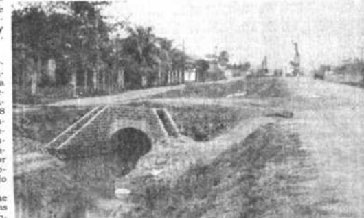
PUNTES URBANOS. La Comunidad Económica Europea (CEE), se apresura a entregar a Trinidad el anillo protector contra inundaciones, construido en los últimos dos años con su financiamiento y una contraparte local. En el proyecto, se incluye una docena de puentes urbanos, de acceso al terraplen que rodea la ciudad. Otros diez puentes son construidos con recursos del Fondo Social de Emergencia (FSE), por solicitud de CORDEBENI (Foto: PRESENCIA-Juca).
