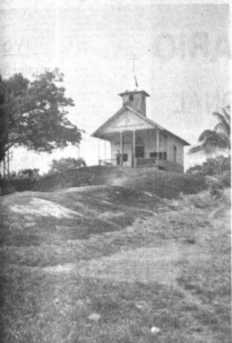
IGLESIA ESPERANZA. Vista de la Iglesia de Cachuela Esperanza (Beni), construida el año 1939, encima de una enorme estructura de piedra, que se asienta en las montañas dentro del espacio geográfico del oriente boliviano.
