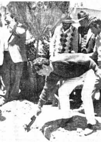
PRIMERA TUBERIA. Con la ruptura de una botella de champán, el representante del Fondo Social de Emergencia inaugura el alcantarillado de Viacha.
