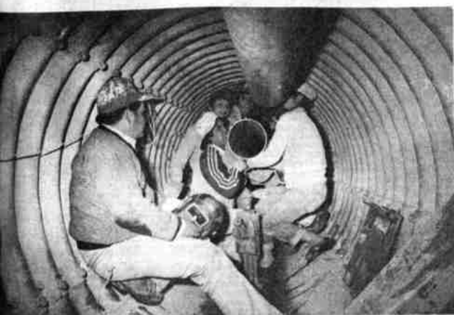
Instalación. Obrero de YPFB trabajan en la instalación de la tubería que se conectará a la línea de gas natural, a más de 100 metros debajo de la autopista hacia la ciudad de El Alto. Los trabajos se realizan en un túnel de desagüe, ubicado en el sector del bosqueillo de Pura Pura, que tiene 160 metros de largo por 90 centímetros de alto.
