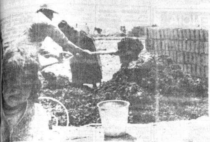
"RELOCALIZADO". Pedro Valdez, minero "relocalizado" de Caracoles, trabaja junto a su esposa e hijos para recoger un cupo de alimentos del programa trabajo por alimentos de Adra-Ofasa para entregar, en los próximos, días 300 adobes; destinados a la construcción de la escuela de la Urbanización 18 de Mayo Senkata.
